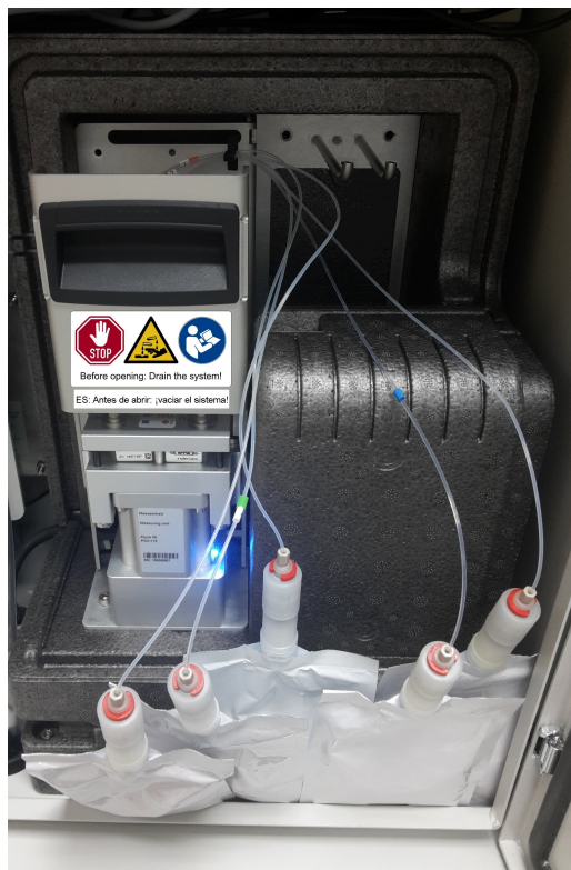
Rysunek 5-7 Zdemontowane chembagi do wymiany
