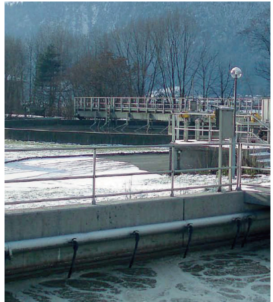
Moderne Großkläranlage: Kläranlage Strass in Österreich
