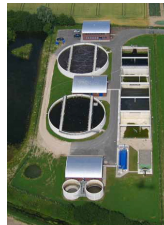
Abb. 1: Luftbild der Kläranlage Glückstadt
