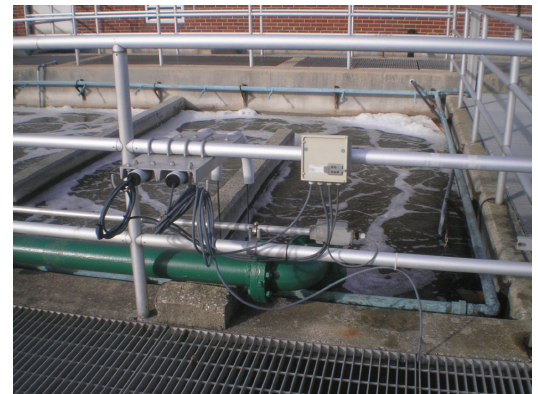
Ein IQ SENSOR NET-Modul, das zusammen mit Sensoren Sensoren zur kontinuierlichen Prozessüberwachung und -steuerung.
