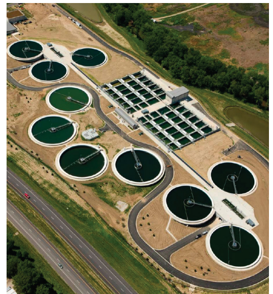
Luftaufnahme der Spring Creek Kläranlage
