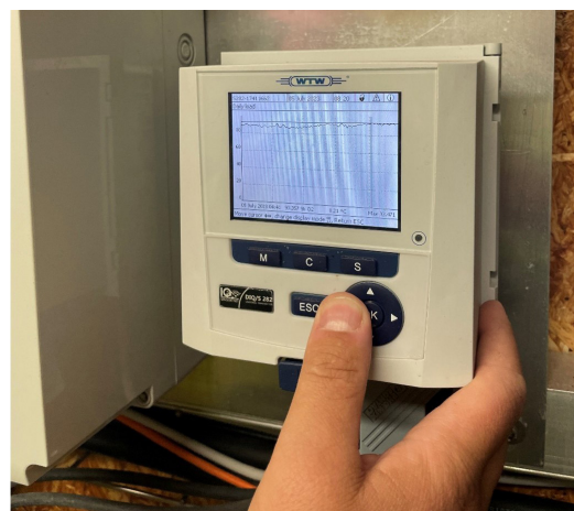
Med en WTW kontroller med skjerm har man hele tiden oversikt over oksygenverdiene i de ulike merdene. Og med disse målte verdiene kan man styre pumper og oksygentilførsel direkte, eller sende signalene videre til PLS. Den har også en nettbasert funksjon.
