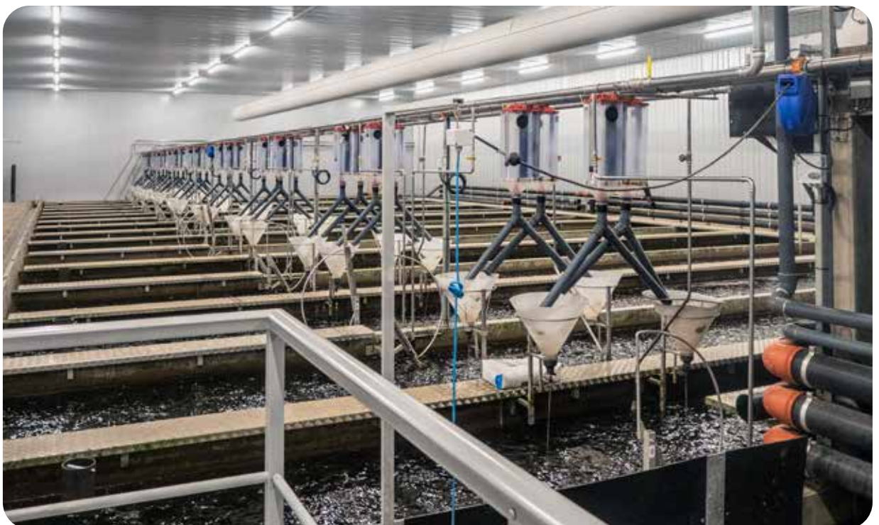
Ein Blick in die FREA-Anlagen
