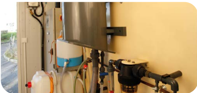
In der Prozesstechnik: TetraCon® 700 IQ Leitfähigkeitssensor mit 4-Elektroden-Messzelle
